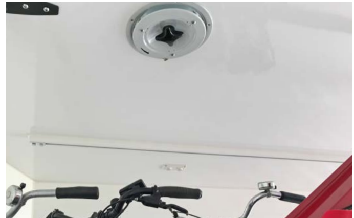
Entlüftung: Unabdingbar, wenn Fahrräder z. B. nass sind
